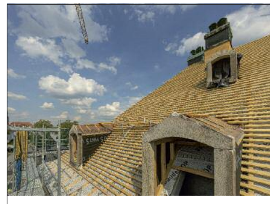
Das Dach des zum Teil denkmalgeschützten Gebäudes wurde im Zuge der Umgestaltung für das Archiv der Avantgarden authentisch wiederhergestellt. Für die Holzkonstruktion der Dachfläche wurden über 70 Kubikmeter Brettschichtholz und bis zu 11 Meter lange Sparren verarbeitet.
