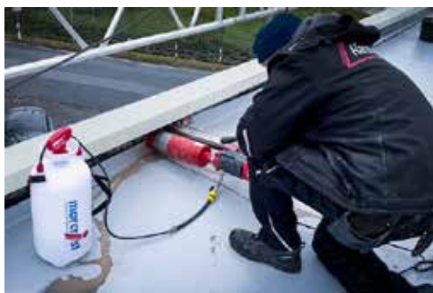
Kernbohrung in die Attika
